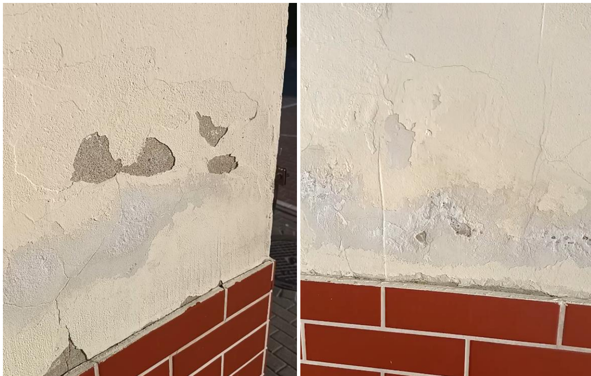
Wilgoć w ścianie zewnętrznej - elewacja pawilonu wysokiego
