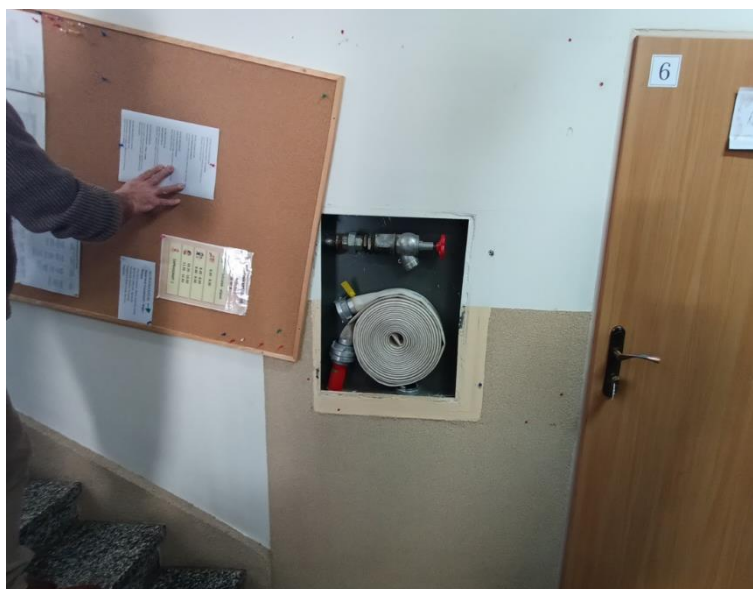
Pawilon wysoki cz. zachodnia – nieczynny hydrant w korytarzu na parterze
