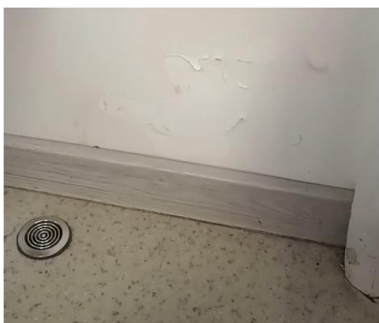
Wilgoć w ścianie zewnętrznej w sali N10 pawilonu niskiego
