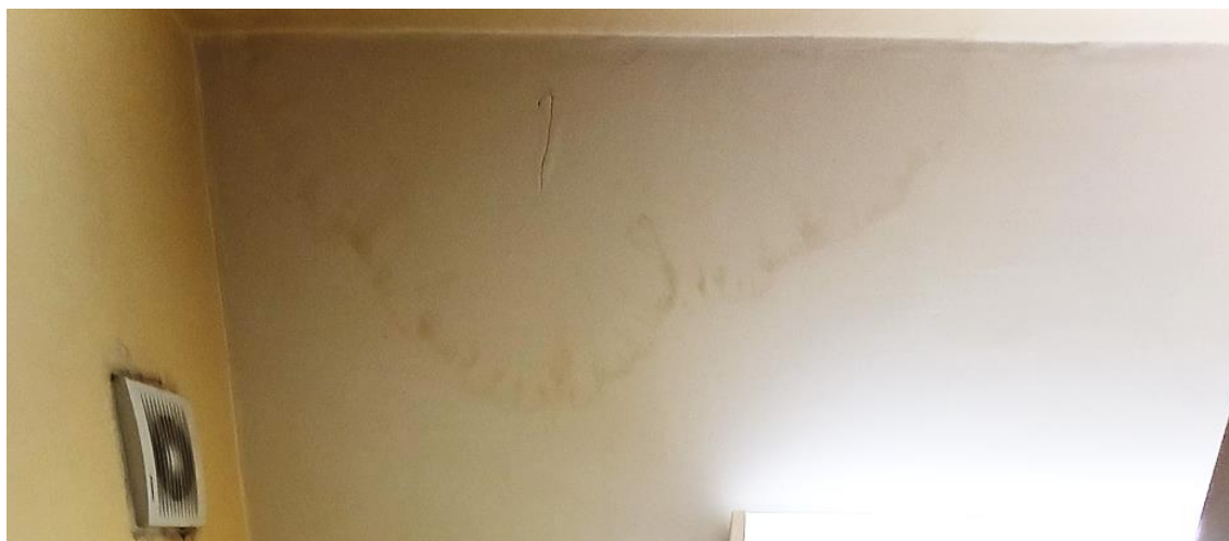
Zaciek na suficie – toaleta, pawilon wysoki zachód
