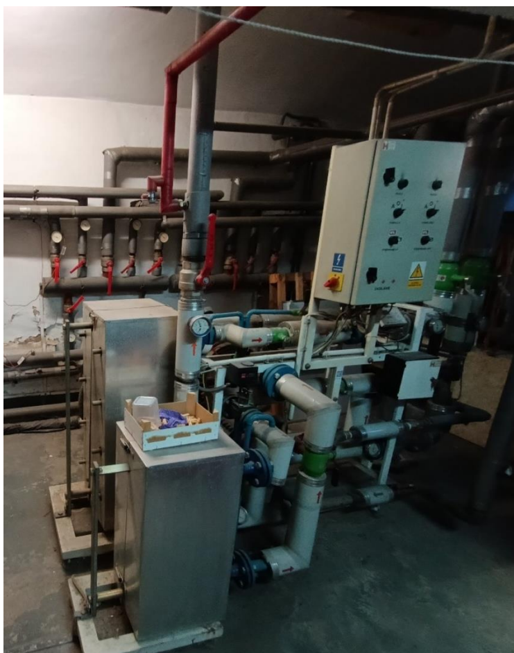
Widok na obiegi grzewcze (rozdzielacze) oraz aparaturę węzła cieplnego
