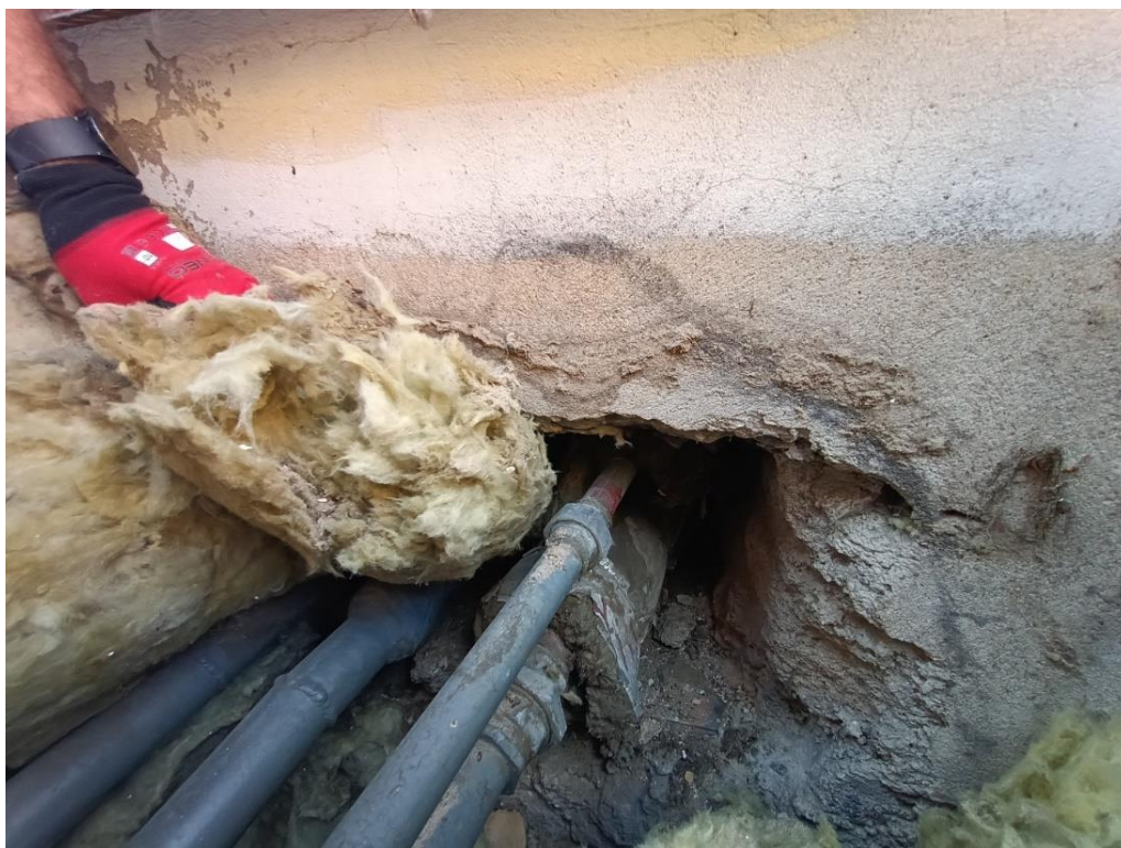
Widok na istniejące rury ciepłociągów.
