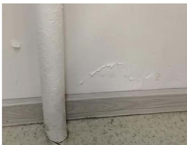
Wilgoć w ścianie zewnętrznej w sali N10 pawilonu niskiego
